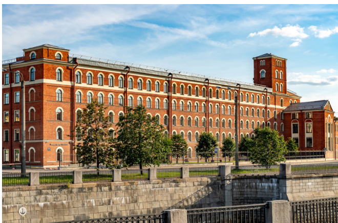
Наб. Обводного канала, д. 60
